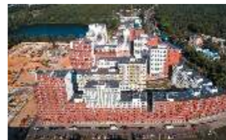
ЖК «Новокрасново», МО «Тройка РЭД»
